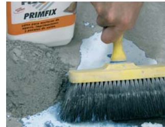
Bonding paste: PRIMFIX + Portland
