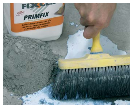
Couche de fixation : PRIMFIX + portland pur.
