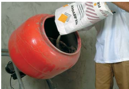
Mortier à la consistance « plastique ».
