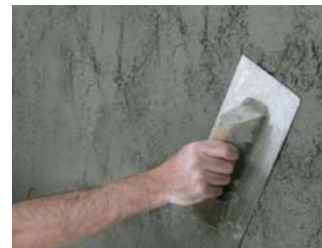
Ove necessario, livellare il materiale.
