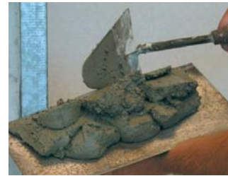
Applicare anzitutto uno strato sottile.
