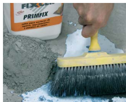
Calda de aderência: PRIMFIX + Portland puro.
