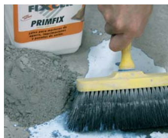
Couche de fixation : PRIMFIX + portland pur.
