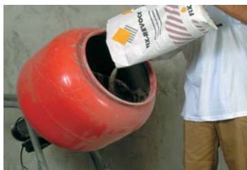
Mortier à la consistance « plastique ».
