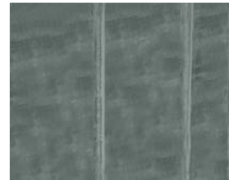
Remplir entre les joints.
