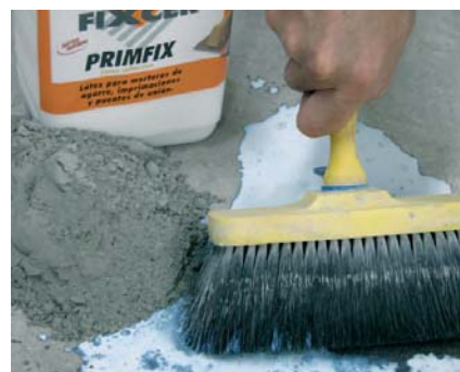
Pont d'unió: PRIMFIX + portland pur.
