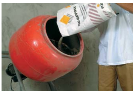
Morter de consistència "plàstica".
