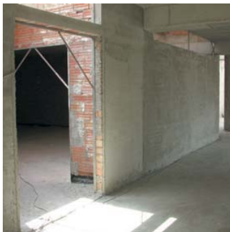
Arrebossats interiors i exteriors.
