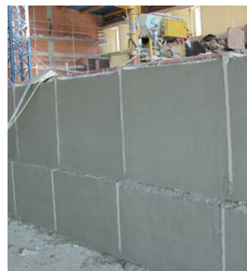
Revocos en piscinas.
