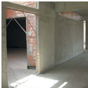
Revocos interiores y exteriores.
