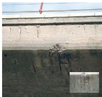
Con FIX-REPAR reparamos estructuras de hormigón.
