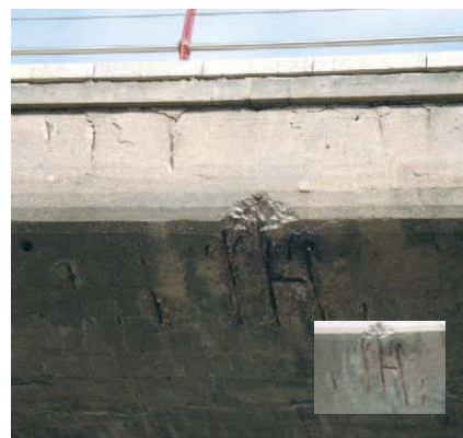
Amb FIX-REPAR reparam estructures de formigó.
