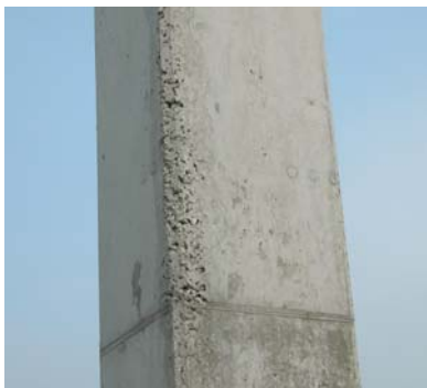
Reparación de pilares.
