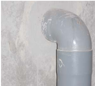
Rellenos entre PVC-hormigón.
