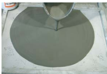
Delimitar el perímetro antes de aplicar el FIX-NIVEL .
