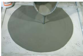
Délimiter le périmètre avant d'appliquer le FIX-NIVEL.
