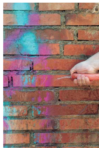
3º.- Eliminar la pintura amb aigua a alta pressió
