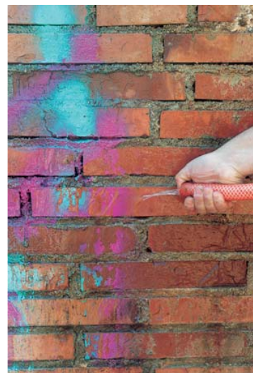
3º.- Eliminar la pintura con agua caliente a alta presión
