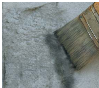
Antes de nada, comprobar la absorción del soporte.
