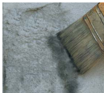
Avant tout, vérifier l'absorption du support.
