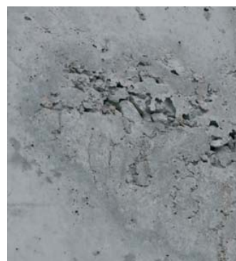
Reparar nius de grava en el formigó.
