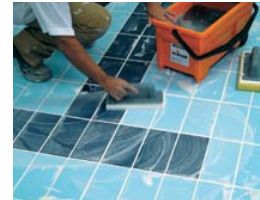
Usar el FIX-BUCKET y la llanas de limpiar.
