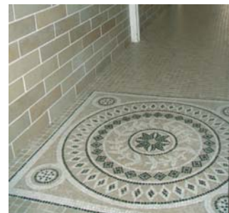
Rejuntat estèticament impecable.
