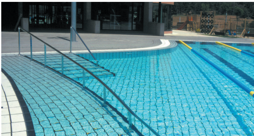
Rejuntat impermeable de piscines.
