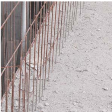
Imprescindible para unir hormigón nuevo con hormigón seco.
