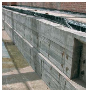
Réparation du béton dans les conditions les plus difficiles.
