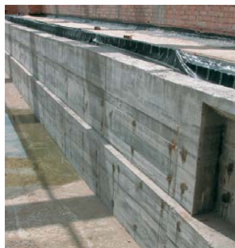
Reparación del hormigón en las condiciones más duras.
