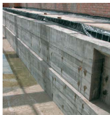
Reparació del formigó en les condicions més dures.
