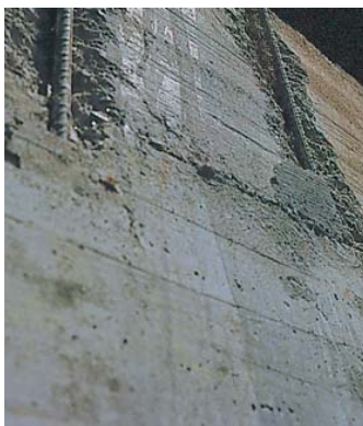
Reparació del formigó.
