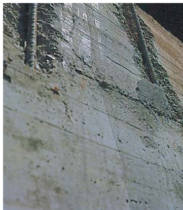
Reparación del hormigón.
