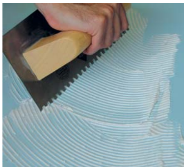
Étalage facile avec la truelle dentée.
