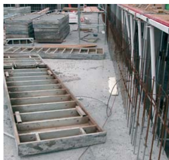
Embutir el FUGA-STOP y hormigonar entre encofrados.
