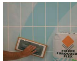
Jointer 24 heures après la pose.
