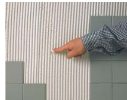
Vérifier que le ciment est frais.
