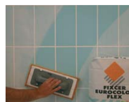
Rejuntar pasadas 24 horas de la colocación.
