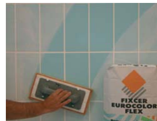
Rejuntar passades 24 hores de la col.locació.
