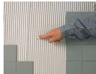
Comprovar que el ciment estigui fresc.
